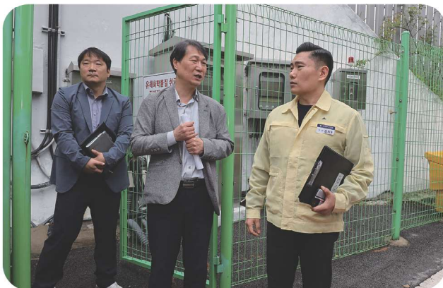
음식물류 폐기물 자원화시설 현장 방문
