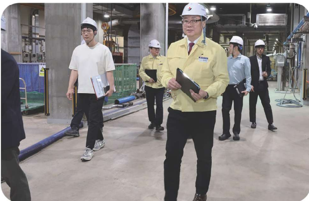
음식물류 폐기물 자원화시설 현장 방문
