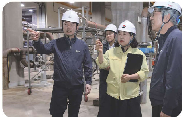
음식물류 폐기물 자원화시설 현장 방문
